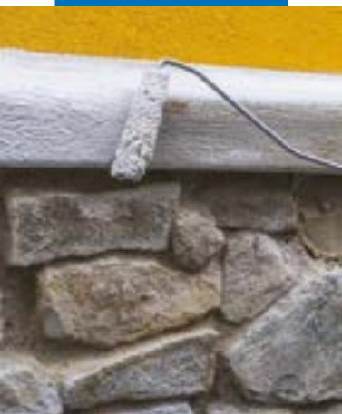
Hydroizolace parapetu zdi s použitím Mape-Antique Ecolastic
