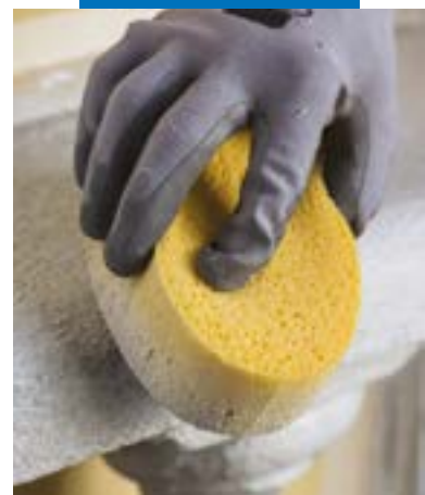
Úprava povrchu Mape-Antique Ecolastic houbou
