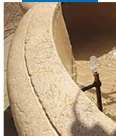
Hydroizolace nádrže kamenné kašny
